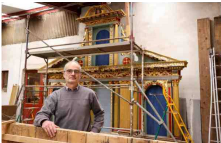
Pour consolider la structure détériorée, le chantier a été confié à Jean-Claude Ayçaguer. PABLO ORDAS / « SO »
