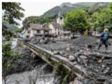
En 2024, après la crue qui a recouvert la haute vallée d'Aspe de boue et de gravats. ARCHIVES DAVID LE DEODIC/SO
