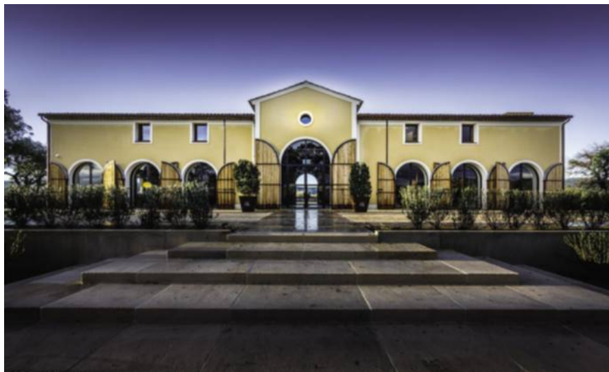
Le chai du château Saint-Maur a été reconstruit en neuf mois, ex-nihilo, au milieu des vignes. PHOTO DR
