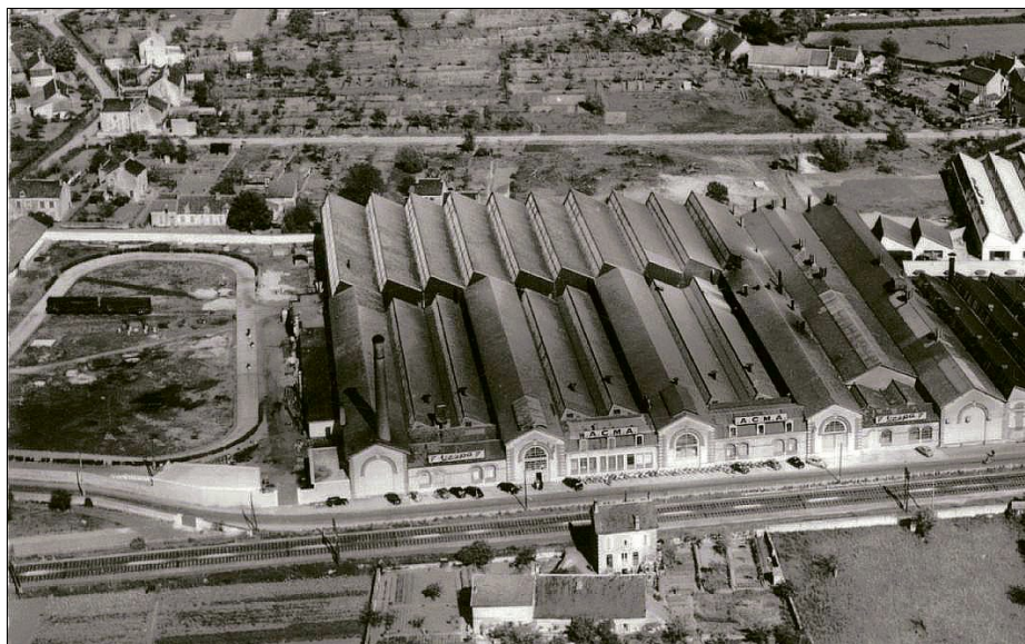
ENSEMBLE. Sur cette vue aérienne de 1956, il est possible de se faire une idée de ce que représente le tènement (ensemble de propriétés contiguës) ACMA, patrimoine industriel à préserver.
