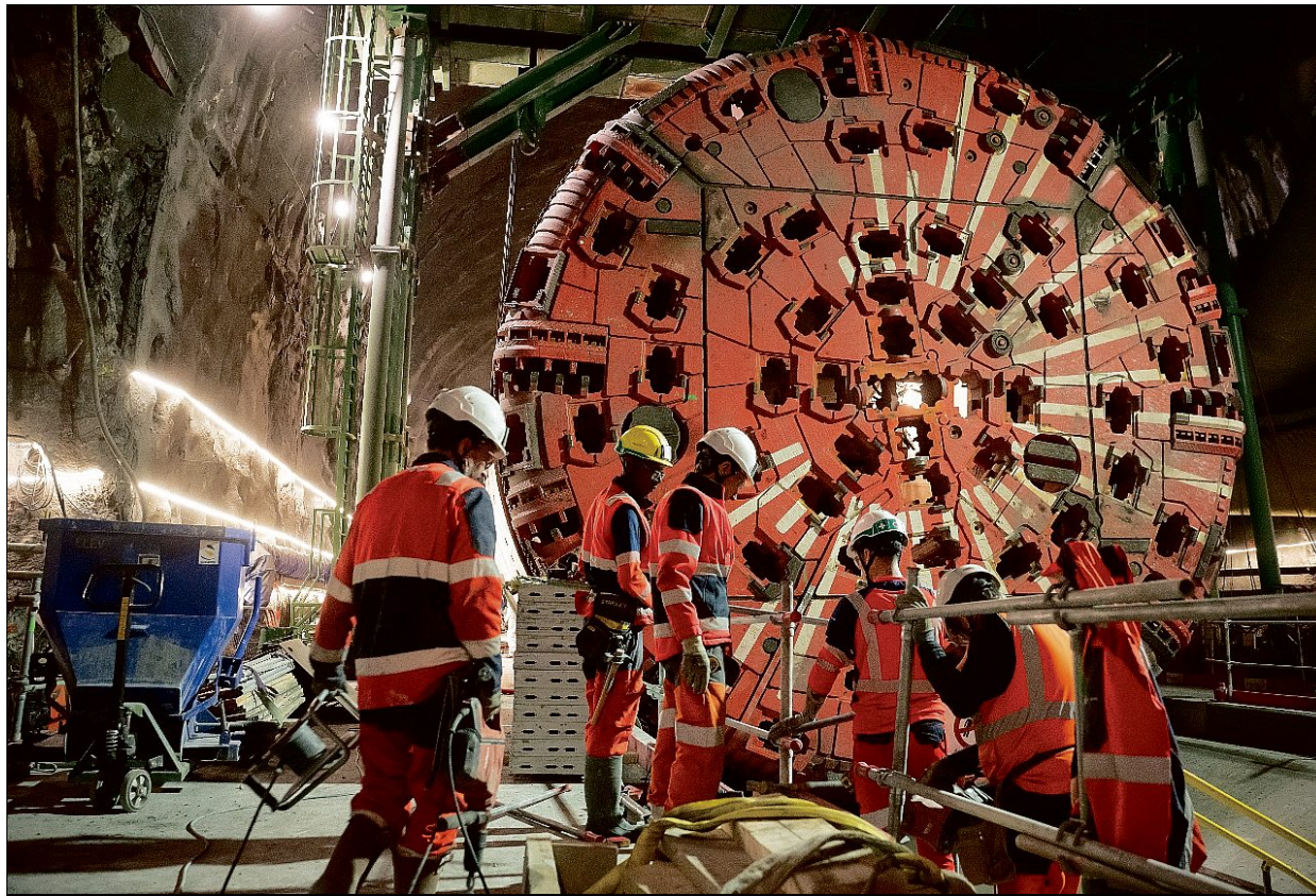
TITAN. Viviana, bientôt à l'œuvre sur le tube nord du Lyon-Turin, est le premier des sept tunneliers géants (10,5 mètres de diamètre) construits spécialement en Allemagne. Démontés avant de quitter leur usine, ils doivent être remontés sur le chantier. PHOTO FRANCK BOILEAU
