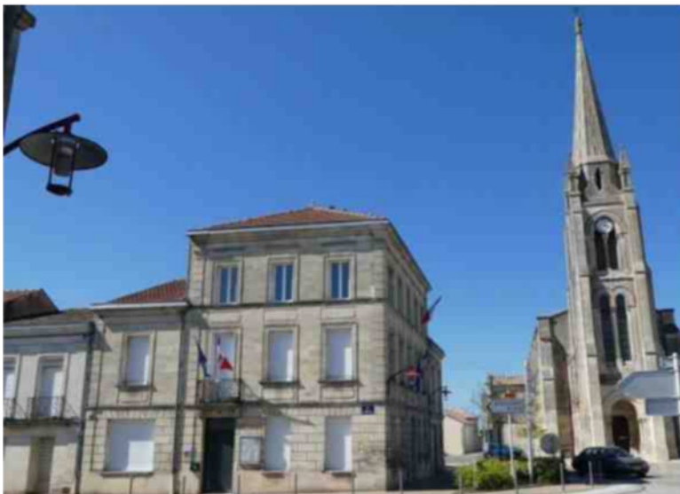
Des travaux sont prévus à l'église, pour un montant de 6 264 euros. P. R.
