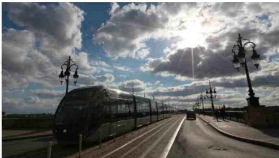
Les transports sont le premier pôle d'investissement de la Métropole, qui engage cet été la rénovation du pont de pierre. ARCHIVES SO
