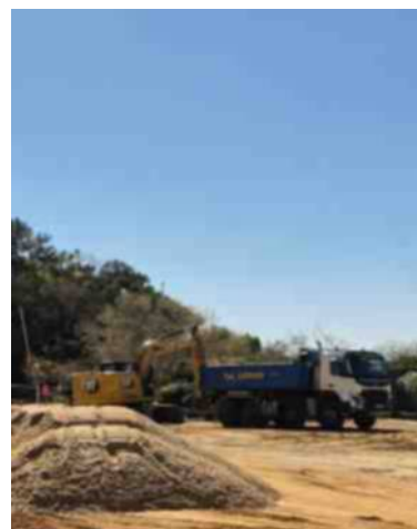
Les travaux sur le parking des Arbousiers. P. B.
