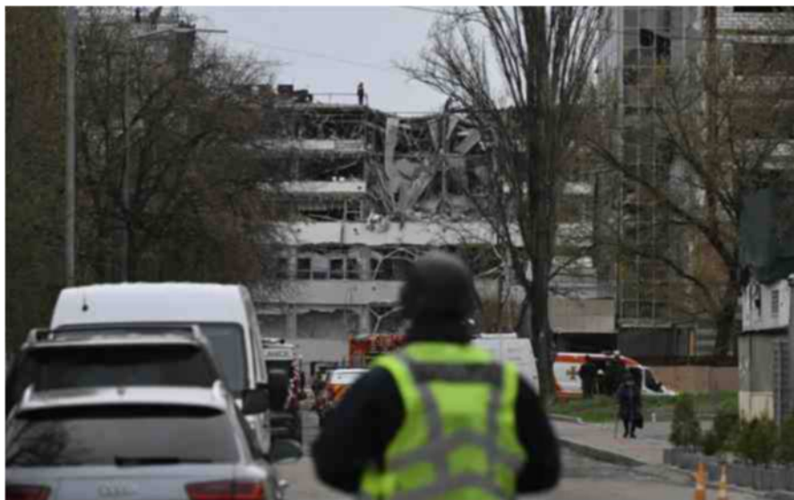
Des incendies ont éclaté à Kiev dans des bâtiments non résidentiels, endommageant un centre d'affaires, une usine de meubles et des entrepôts. GENYA SAVILOV / AFP
