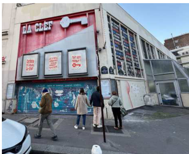
Les travaux de remise aux normes de l'établissement, racheté en juin, ont débuté depuis quelques semaines.
