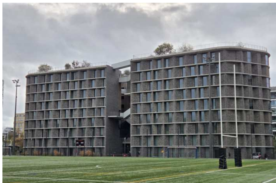
Imposante, la Maison de la Chine déploie ses 8 000 m 2 sans avoir encore accueilli le moindre étudiant, alors que la capitale connaît une profonde crise du logement.
