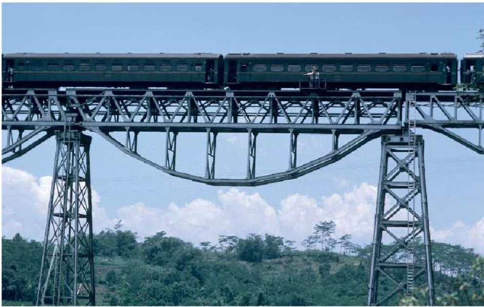
Le parcours est ponctué de dizaines de ponts à claire-voie.
