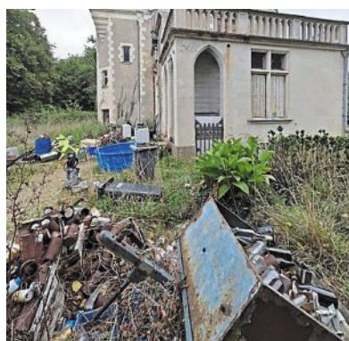
D'importants travaux sont nécessaires pour réhabiliter le château de Vau.
