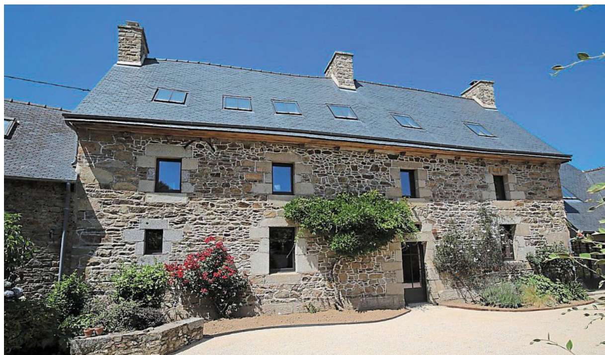
L'ancienne ferme rénovée sans la dénaturer, avec ses ouvertures sur le toit.
